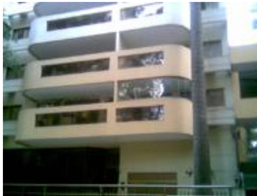
Fig.9: varanda fechada com esquadrias de vidro Fonte: acervo próprio, 2008
